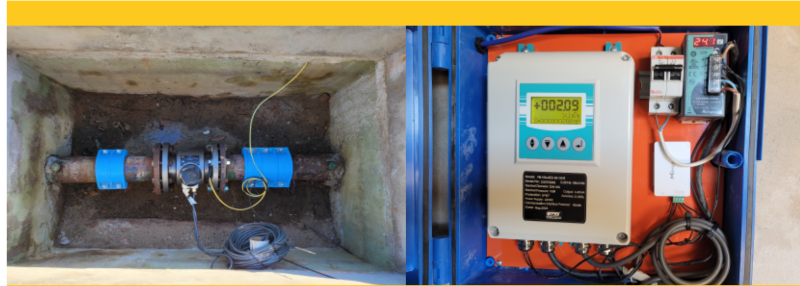
FIG 1. MACROMEDIDOR EN PLANTA
